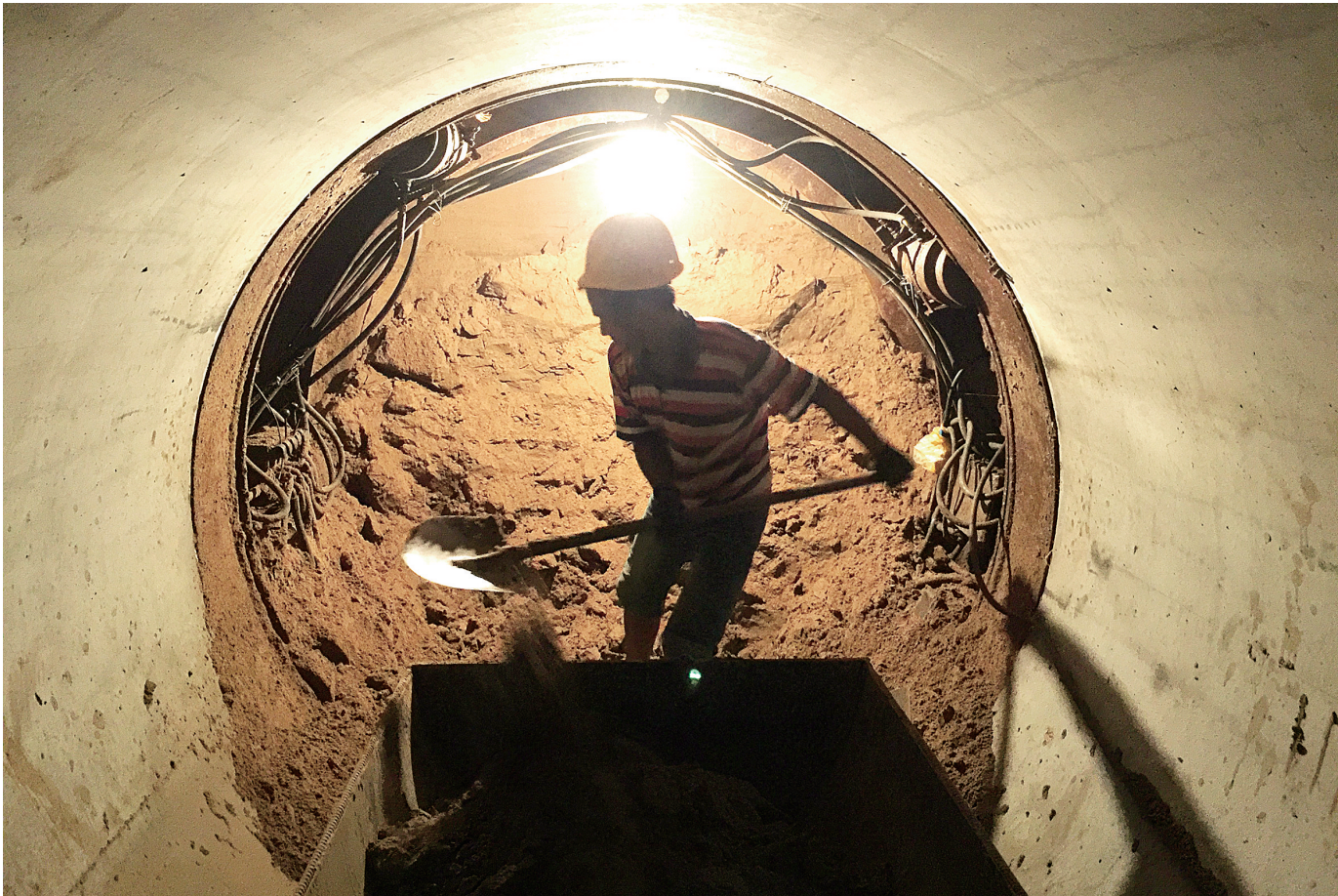
金水大道给水改迁工程下穿京港澳高速顶管施工现场
