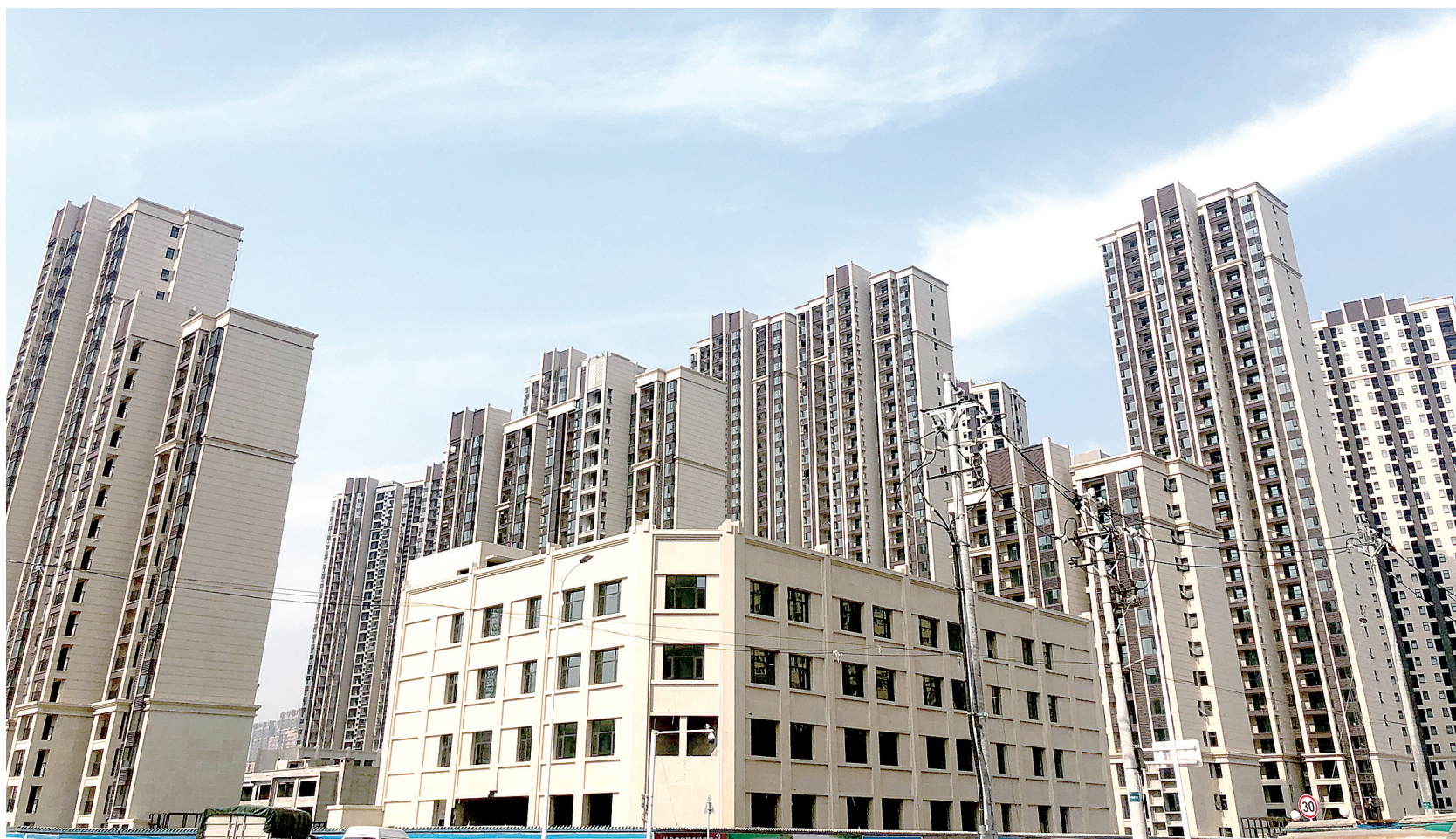
路砦安置房工地现场
