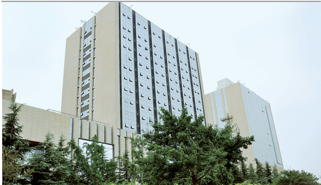
投资62.9亿元的重点项目龙都汇大厦主体建设已完工
