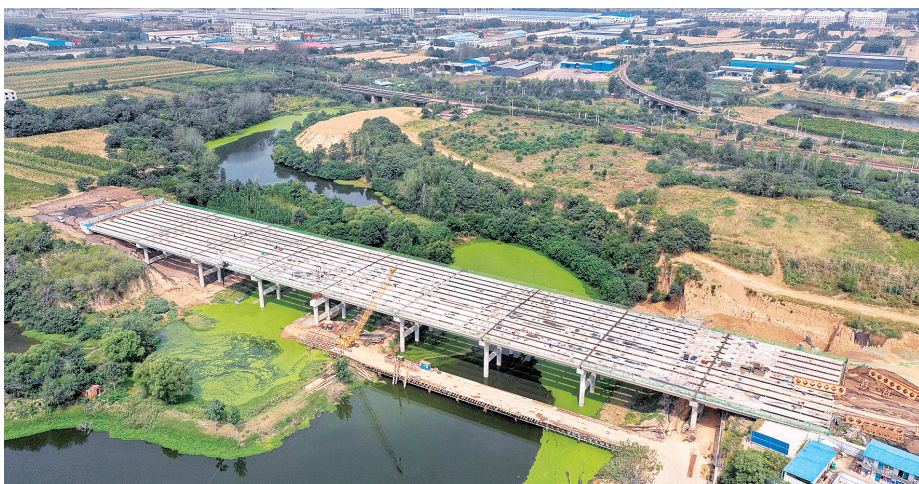
荥阳市兴华路北延跨索河桥工程现场
