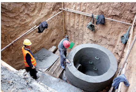
雨污水网施工
