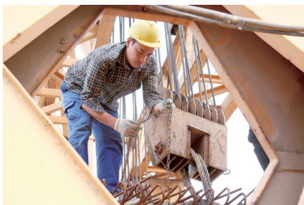
兴华路北延桥梁首片箱梁架设
