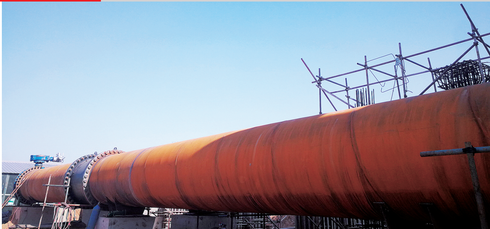
厂内供热出厂管网
