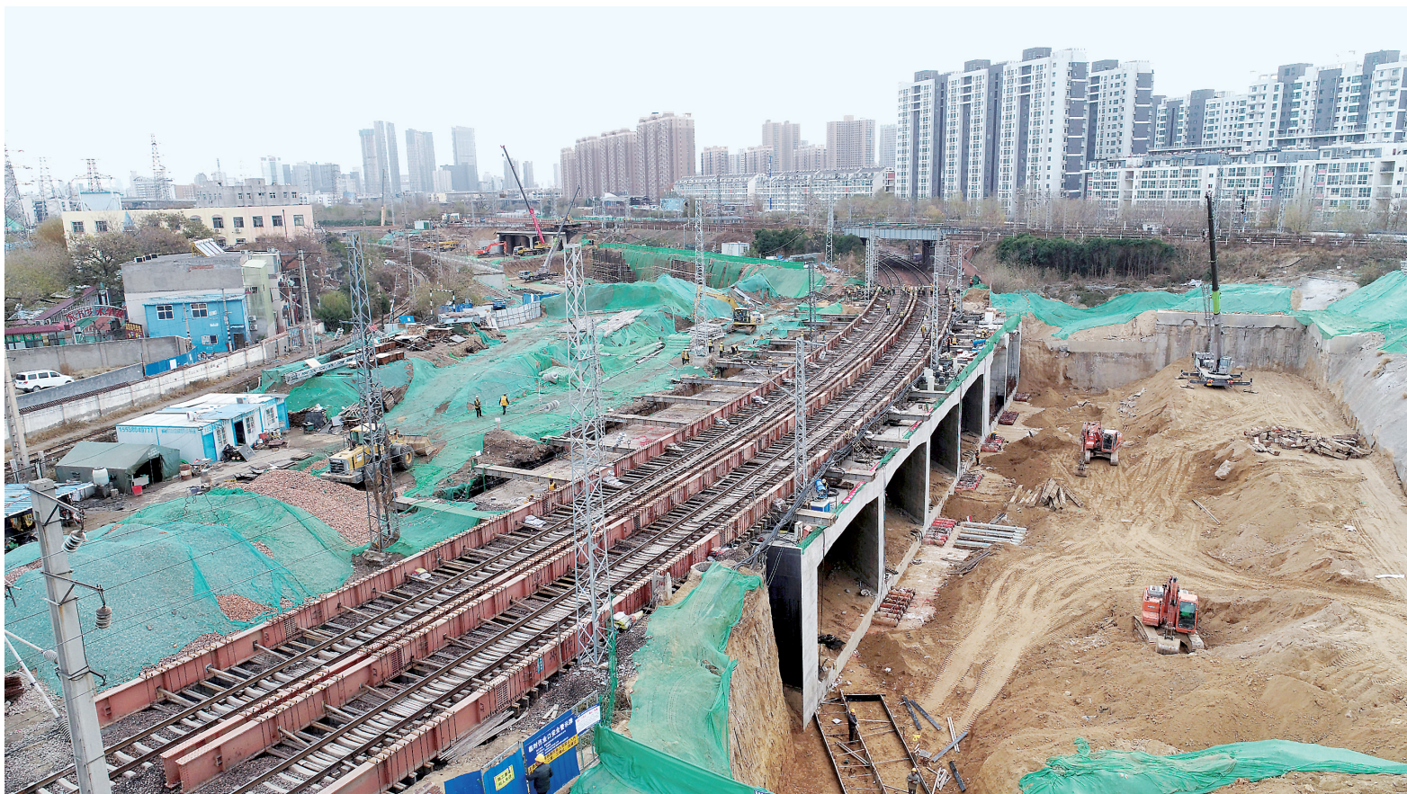
中原地区下穿铁路顶力最大、单体最重最大的框架立交顶进箱桥——金水路西延 3 号箱桥顺利顶进到位,为金水路西延全线开通奠定坚实基础。 记者 黄永东 曹婷 通讯员 孙俊杰 刘顺贤 图
