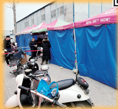
庙张安装点已安装挡风围挡
