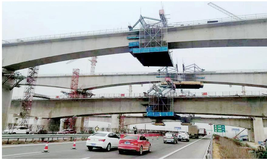
记者在现场了解到,中铁四局郑州南站项目桥梁下部工程已全部完成,路基填筑已全部完成;箱梁预制共786榀,完成比例60%;箱梁架设共786榀,完成比例30%。重点控制性高危工程跨商登高速五联连续梁全部采用
