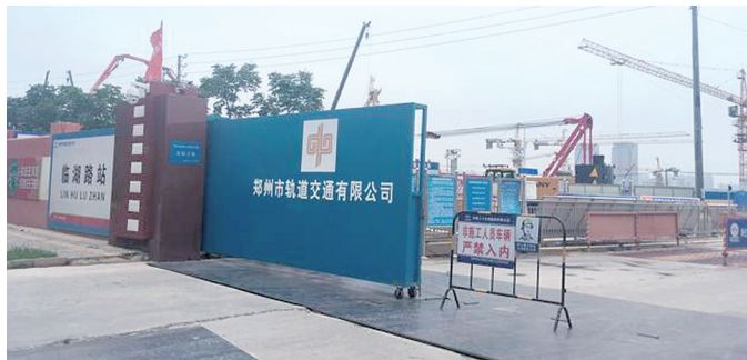
常西湖新区内的地铁线路正在紧张建设
