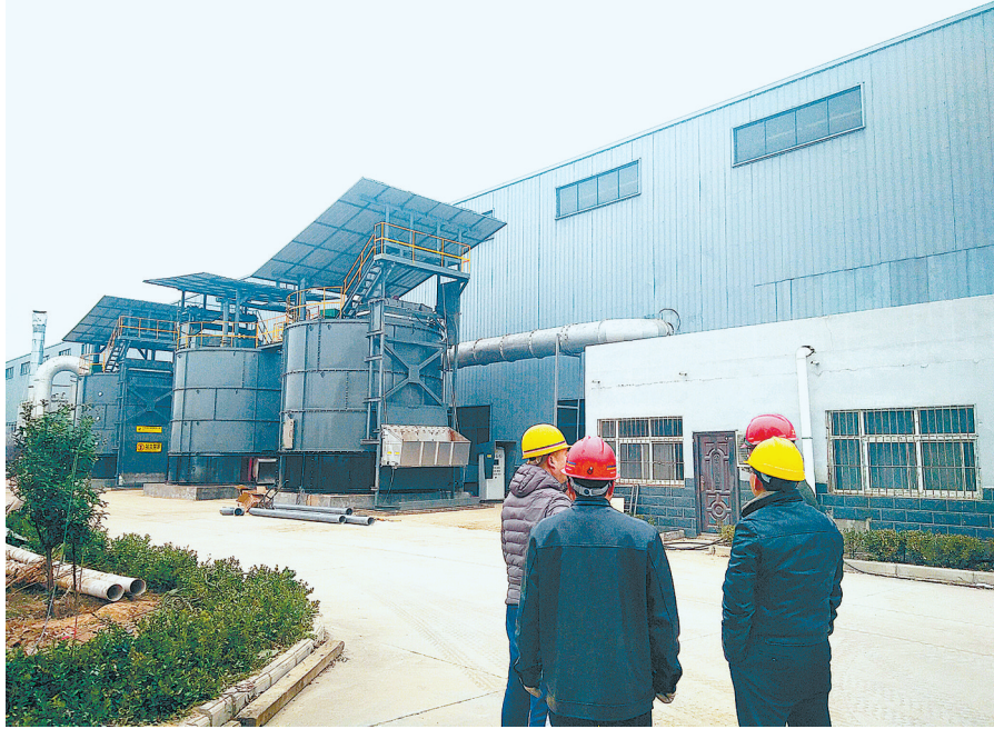
荥阳首个污泥无害化处理项目投入试运行
