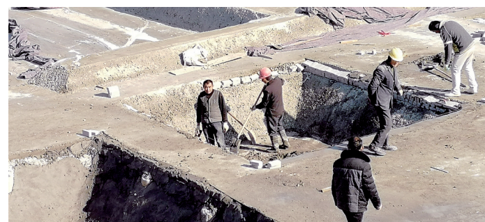
古荥镇一工地数名工人露天搅拌水泥
