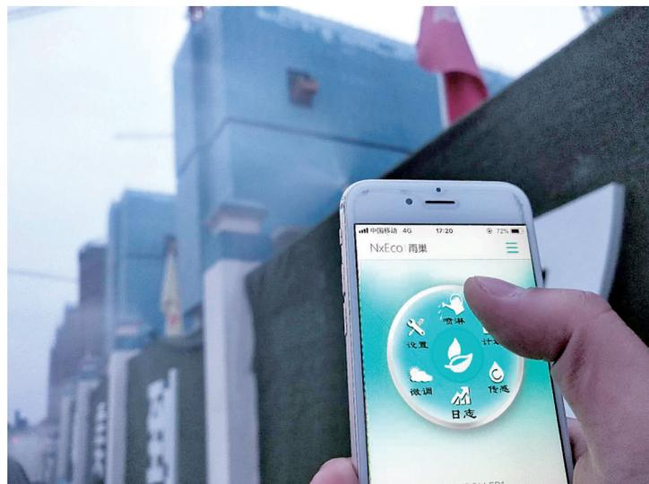
本报讯 12月24日,荥阳市清华大溪地项目11号院建筑项目负责人为参观者做了个演示:当PM2.5监测浓度超过设定的程度时,喷淋系统立即启动,工地上的扬尘便降到设定的范围内。据了解,利用互联网信息技术实现建筑工地扬尘自动治理的做法,在荥阳市尚属首例。
