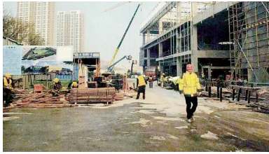
宜家家居郑州商城项目工地
