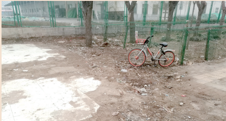
经北六路路面破损、黄土裸露
