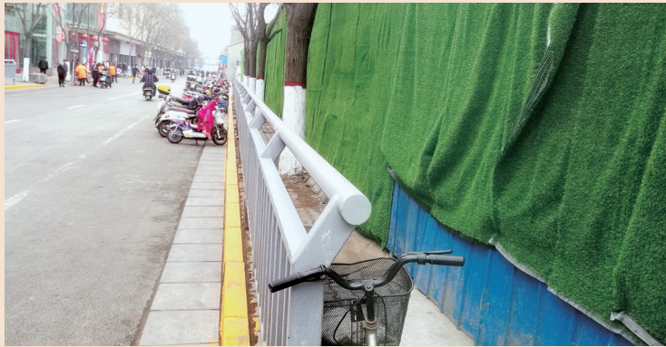
东三马路一工地围挡占用人行道
