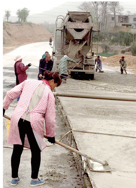
富民路建设项目施工中
