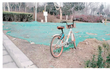
金光路办事处 郑开大道北 (东四环-桑林北路) 道路分类:A类 二级路长:刘建业 存在问题:机动车乱停放;共享单车乱放;暴露垃圾;废弃物;架空线缆;围挡不规范;围挡破损;无公益广告;人行道板病害;车行道病害;裸露黄土。 整改措施:与相关单位及时对接,查找来源,然后及时整理到位。依托“路长制”结合办事处实际,根据办事处的具体安排,落实好每项工作,做好巡查,做好日常处理,做好协调。
