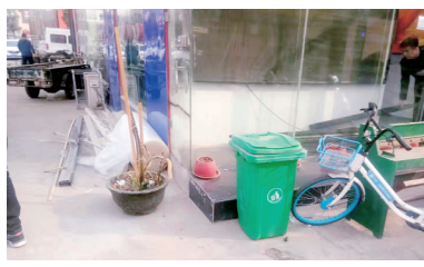
祭城路街道办事处 白庄街 (商都路-宏伟街) 道路分类:C类 二级路长:吕晓晶 存在问题:机动车占压盲道;乱堆乱放;废弃物;边石破损;护栏倾倒;路面破损;门前四包不到位;小广告;共享单车乱放乱停;路面不洁净。 整改措施:组织多部门联动对机动车违章占压人行道进行依法拖车;“地毯式”清理沿街小广告;联系市政及社区物业及时进行路面修补更换。加大巡查频次及治理力度,实现管理的全天候和连续性。
