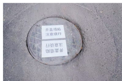
巡查员将提醒标语贴在塌陷的井盖上
