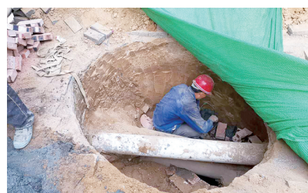
大海寺路污水管网施工现场
