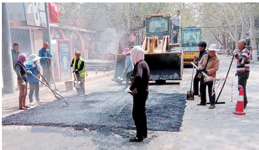
河阴路污水管网建设完工后路面恢复
