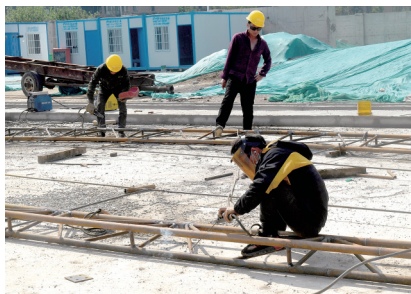
工人露天电焊
