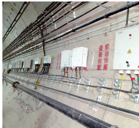
地铁5号线隧道中的5G基站
