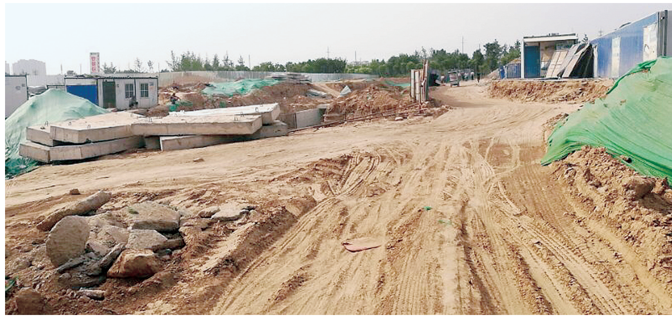
柳湖办事处永威西郡周边多条道路积尘严重
