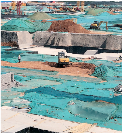
乔楼安置区工地施工现场
