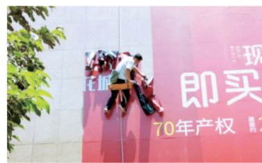
整治力度,将整治“重拳”延伸至小区内,力争做到不留死角、全覆盖式整治,有力助推路长制市容面貌大提升。
