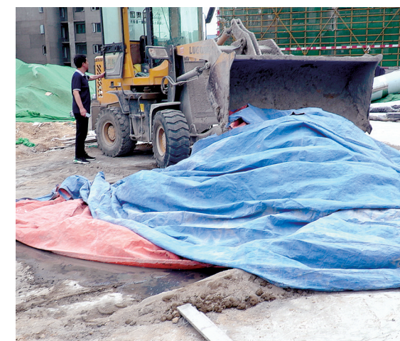
万科城七期工地露天搅拌
