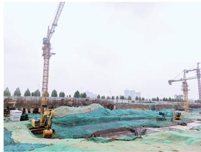
淋设备,并针对如何降尘采取了一系列举措,比如专门安排10名工人负责工地清扫和防尘网铺设维护,确保工地内环境整洁,此外还在门口安装车辆清洗设备,新增智能显示屏,保证每一施工车辆都冲洗彻底后予以放行。“下一步,我们将继续加大对工地降尘的力度,加大喷淋设备作业时间,加重工地全覆盖力度,加强进出车辆管控,确保各项降尘措施扎实开展,还新密百姓一个绿色环保的施工工地”。
