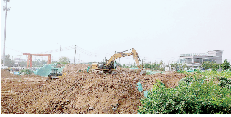
西三环陇海路口西南角无名工地
