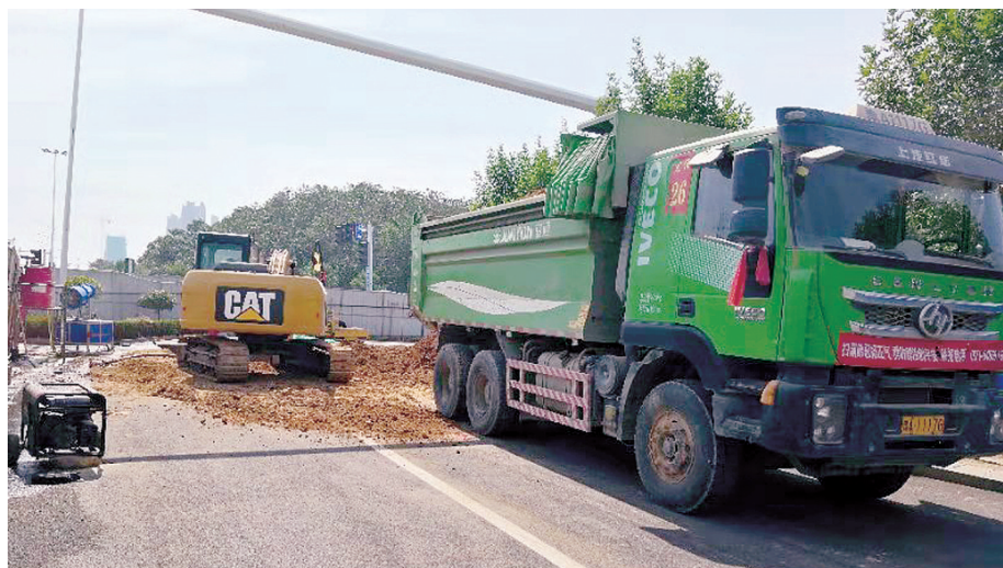
巩义伏羲路滨河路口市政热力工程工地
