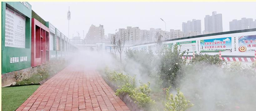
5月份以来,街道以位于漓江路南三环的一工地为试点,督促建筑工地不断提升标准化水平,在打造花园式工地以达到“颜值”过硬之余,工地安装了智能联动降尘设备,实时监控项目的噪声、PM10、PM2.5、TSP等数据,监测工地数值超标情况下可远程通过手机APP和PC端电脑远程一键启动
