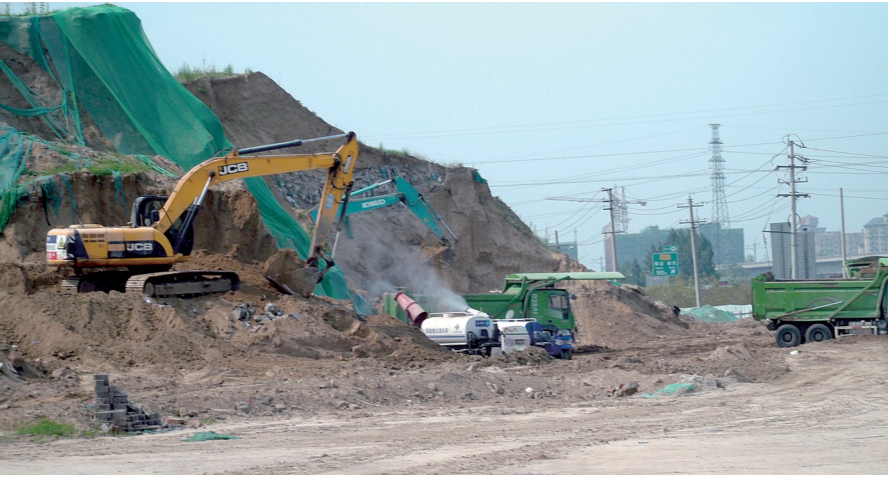
互通立交工地现场
