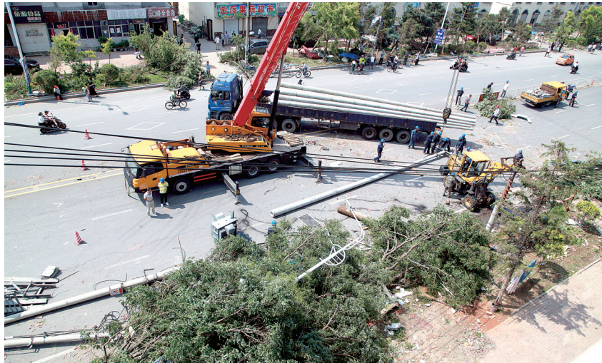
7月4日,救援人员在开原经济开发区受灾现场进行道路清障和电力抢修作业
