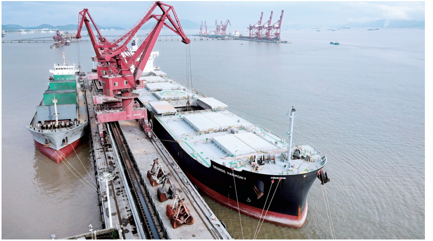
东线行程目的地:宁波舟山嵊山岛。图为舟山市老塘山三期码头。
