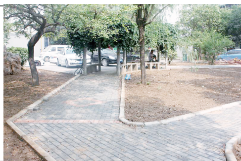
正在改造施工中的金祥社区
