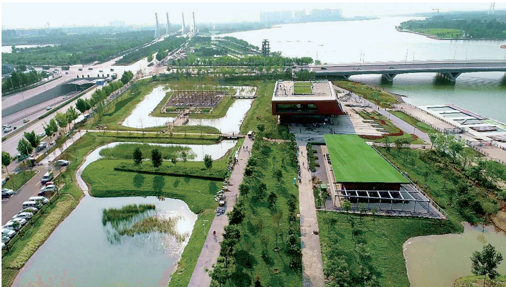
龙湖水上基地包括4300平方米新建及改造建筑、11.5万平方米场地景观提升、4万平方米水域修整。 郑报全媒体记者 马燕 李江 通讯员 张金磊/图
