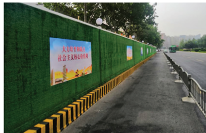
将车站周围破损的施工围挡统一用绿草皮翻新并规范张贴公益广告
