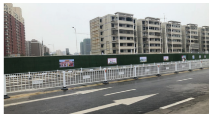
对保通道路破损路面进行修补、重铺,并规范设置护档、警戒指示线
