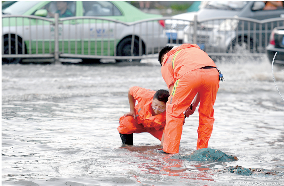
积水中疏通下水道、保证排水的市政工作人员
