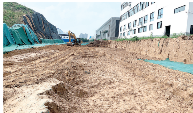
荥阳市牡丹路道路工程施工现场
