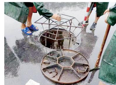
守金力说,经过反复思考和调查,他认为窨井盖被顶飞原因是强降雨导致雨水管涵压力猛增。根据这个思路,守金力画出设备图纸并加工出成品,经试验改进效果不错。目前郑州各区市政部门已按照要求,参照设计并抓紧制作应用。
