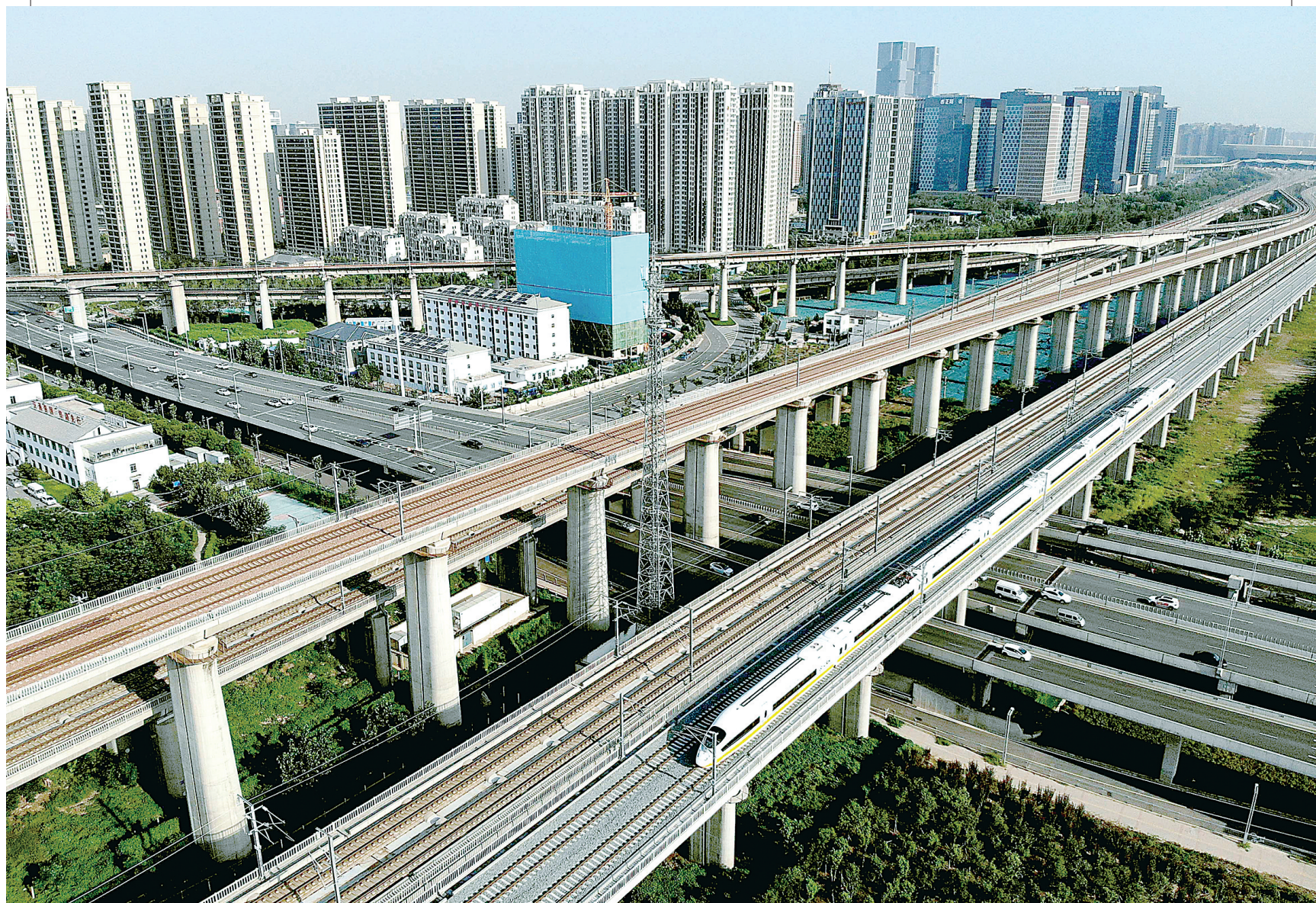
8月18日，高速综合检测列车行驶在郑州东站附近的线路上(无人机拍摄)。 新华社记者 李安 摄
