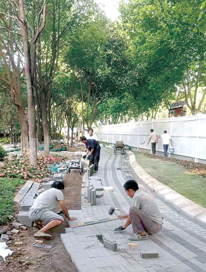
施工人员正在进行最后的游路铺装
