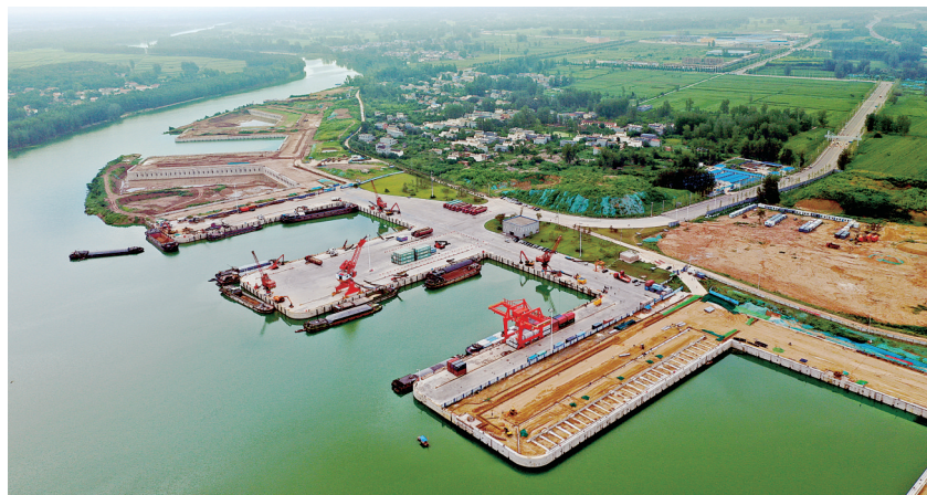
河南周口中心港码头(7月31日无人机拍摄) 新华社发
