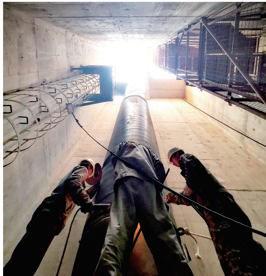
工人在铺设供水管道
