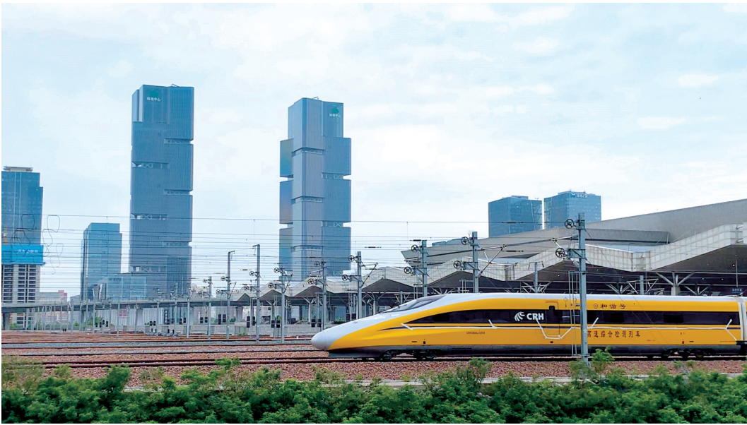
8月13日郑万铁路河南段开始联调联试 郑报全媒体记者 张倩 通讯员 赵晶晶 闫波 栗璋鹏 图
