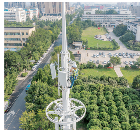
网络维护人员在基站铁塔上方高空作业
