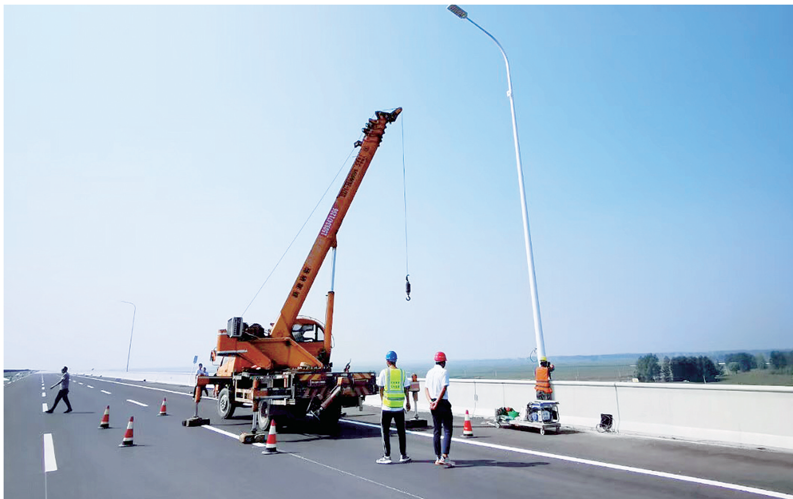
目前,官渡黄河大桥桥面标线已经划好,工人正在架设路灯 郑报全媒体记者 张倩 通讯员 宇娇 侯凯耀 文/图
