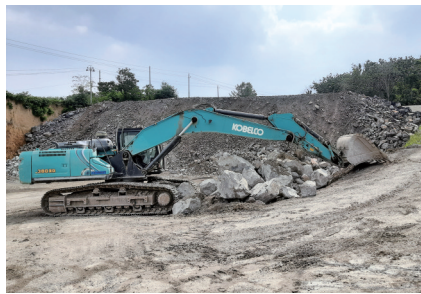
易元祥石材厂区大量原料未遮盖
