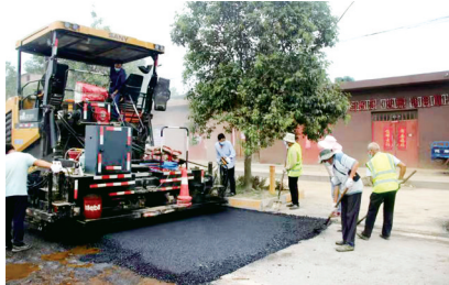
修复损毁道路
