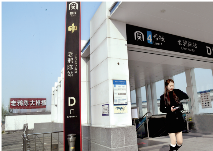
郑州地铁4号线老鸦陈站
