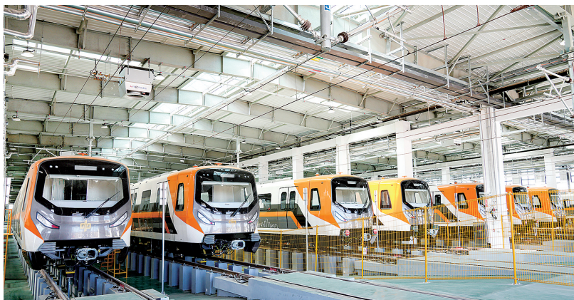
8号线橙色列车从梧桐街停车场出发
