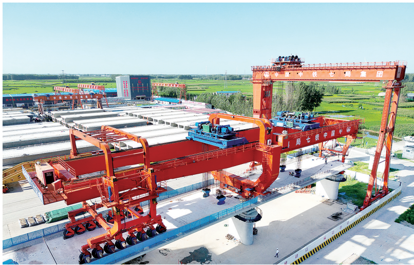
平漯周高铁周口段首台JQ900A型架桥机顺利上桥拼装完成
