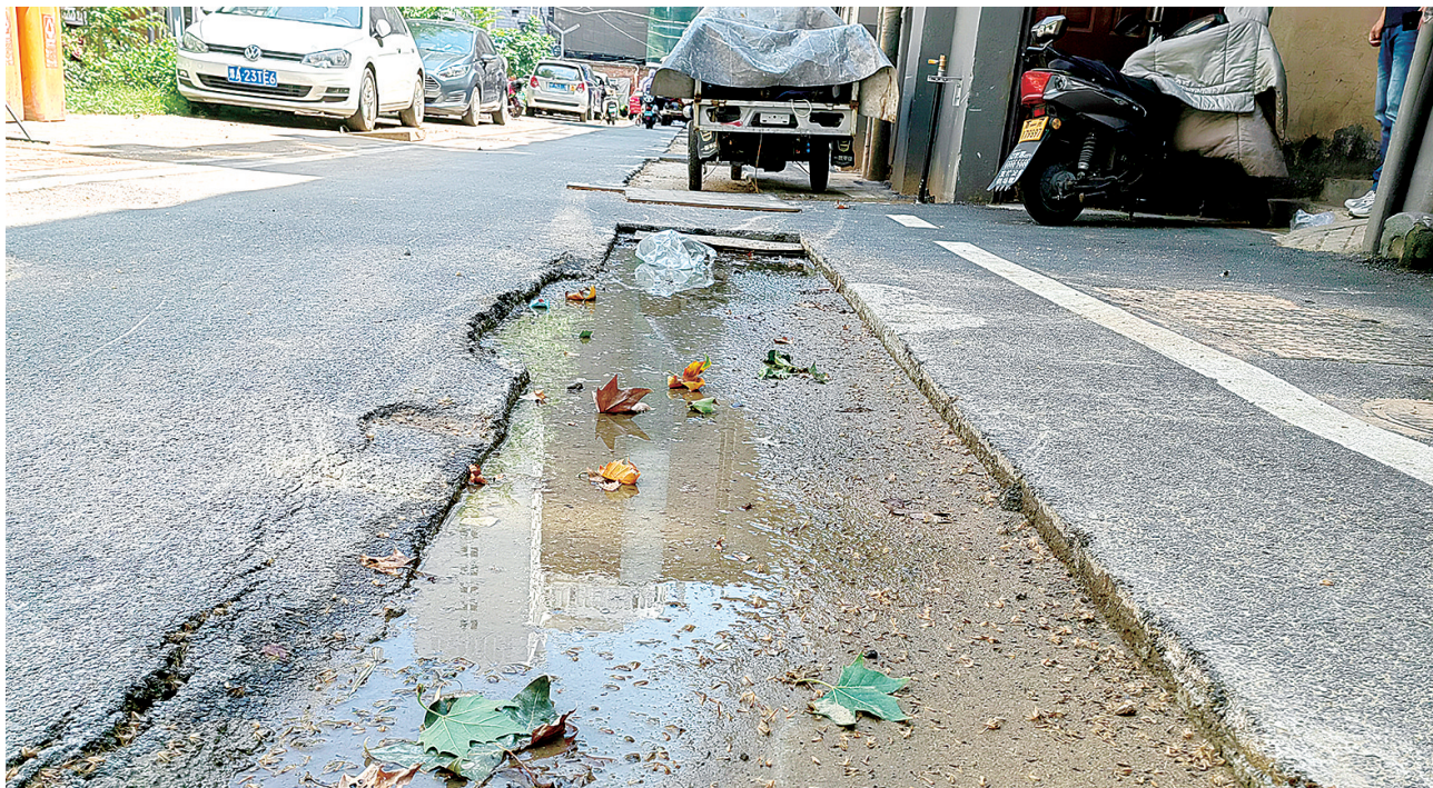
挖开的路面给居民生活带来不便
