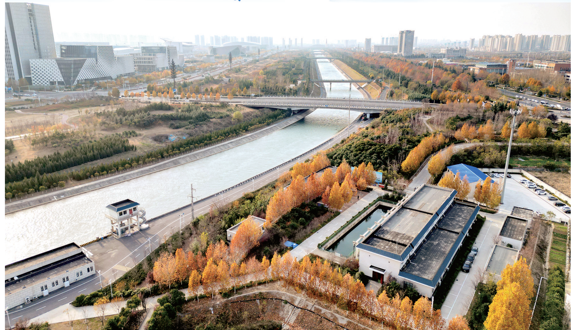
南水北调郑州中原西路泵站
