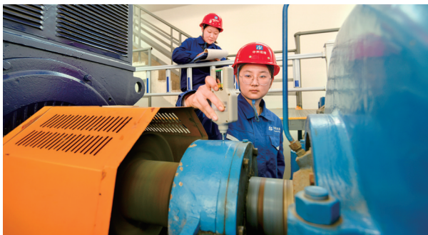
工作人员对机组轴承振动进行检测
